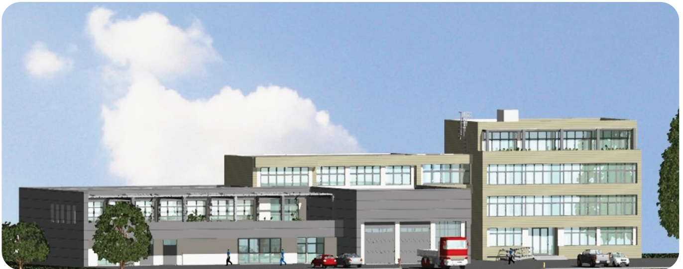
Izgled rekonstruisane KCS „Mostar“
